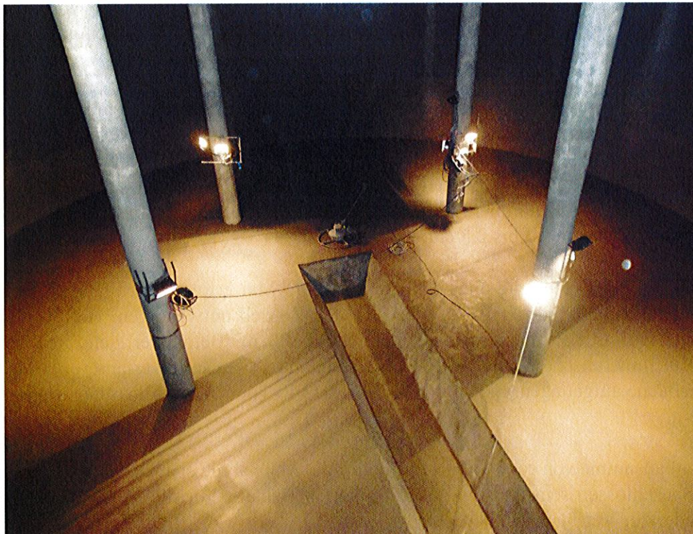
Behälterkammer teilweise saniert
