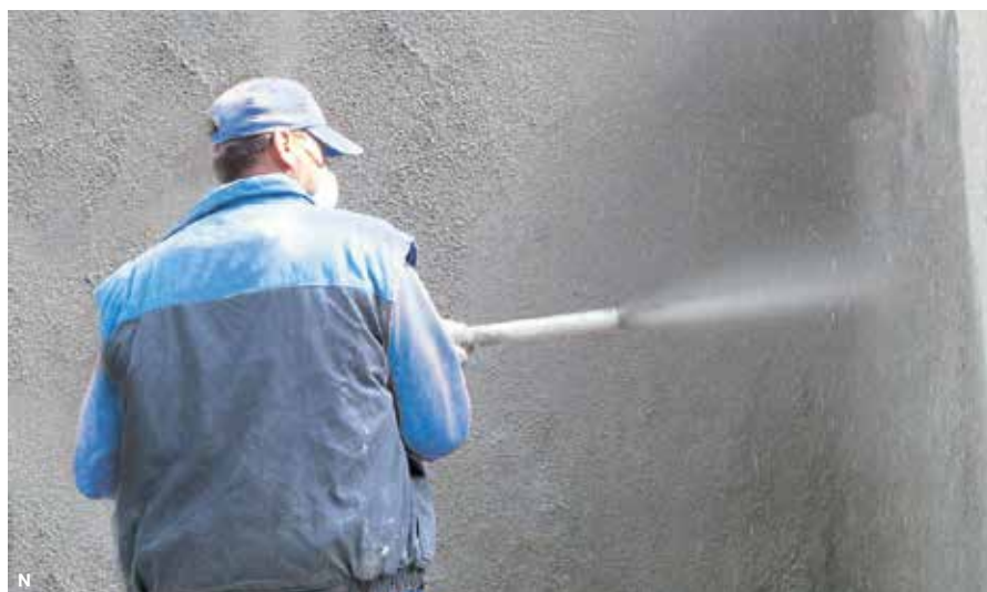
N. Innenwandbeschichtung mit Kerasal® ANS | O. Kerasal® weiß beschichteter Trinkwasserbehälter | P. Hochbehälter Scholven – Blaue Röhre, Foto: Gelsenwasser AG
