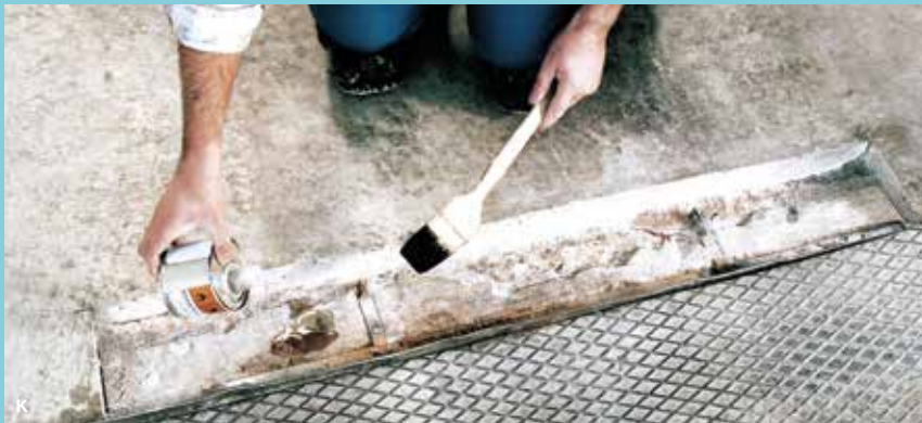
K. Ein Industrieboden-Übergang wird nach dem Ausfräsen grundiert | L. Und anschließend mit einem gefüllten Harzmörtel beschichtet
