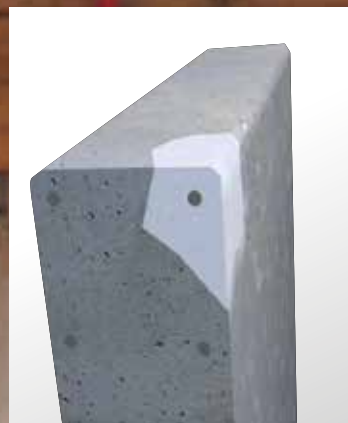
3. Schadstelle mit EuroCret® Feinmörtel auffüllen und spachteln
